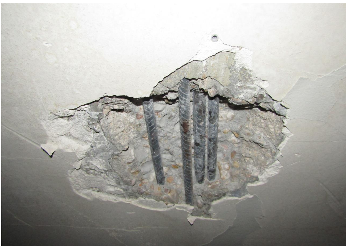
Figura 2-43 Cata P4-5. Acero sin pérdida de corruga. Signos de humedad en el hormigón alrededor de la cata.
