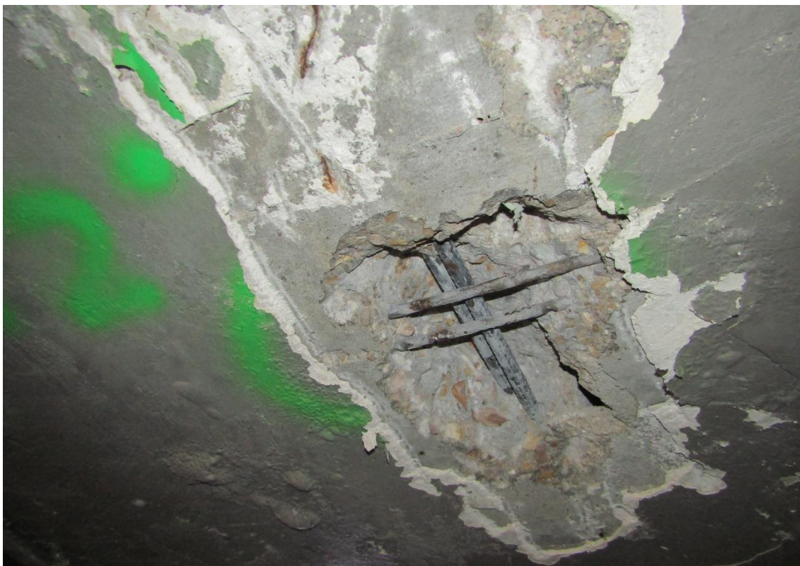
Figura 2-18 Cata P2-3'. Acero sin pérdida de corruga. Signos de humedad en el hormigón alrededor de la cata.
