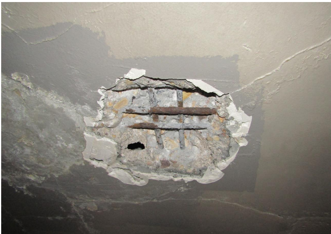
Figura 2-16 Cata P2-2. Acero con pérdida de corruga puntual.
