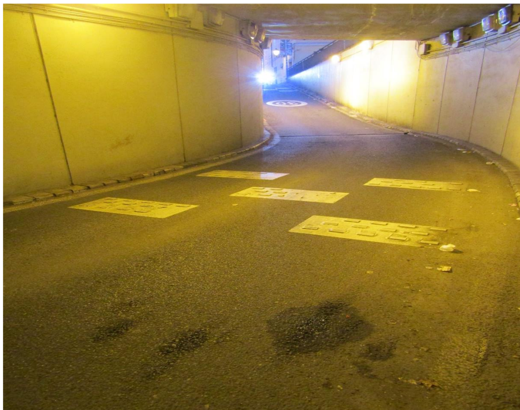
Figura 1-15 Manchas de agua que gotea por la cubierta.
