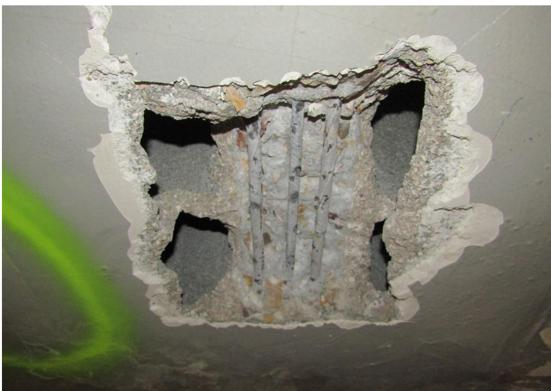
Figura 2-23 Cata P2-8. Acero sin pérdida de corruga. Signos de humedad en el hormigón alrededor de la cata.
