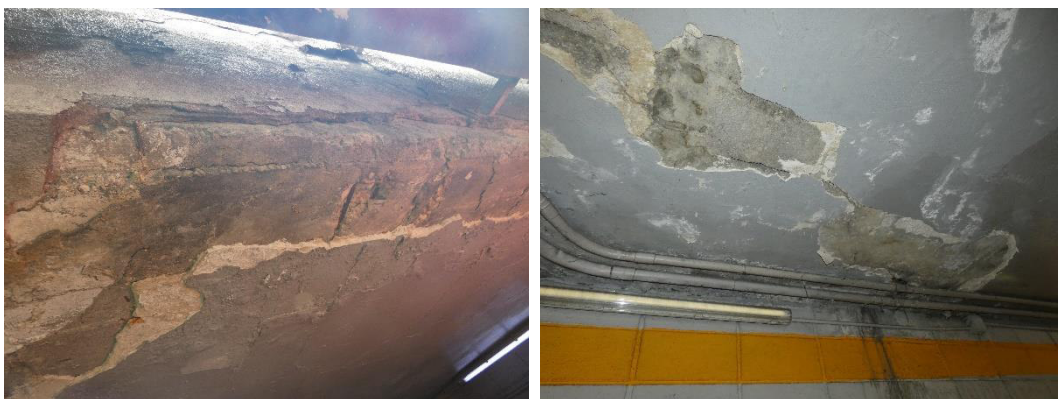
Figura 1-7. Pérdidas de recubrimiento en la rampa al sótano -1 (izquierda) y manchas de humedad con fisuración (derecha)
