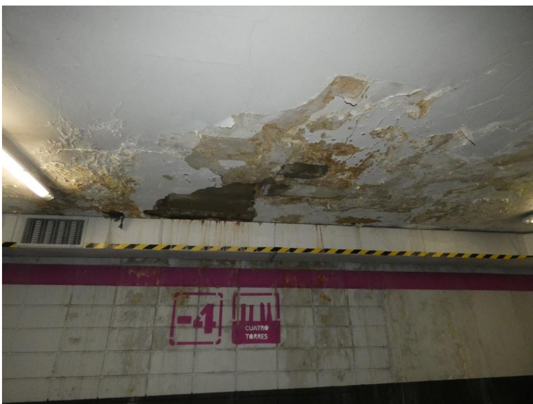
Figura 1-4 Ejemplo paño de forjado de sótano -4 con alto nivel de humedad percibida.
