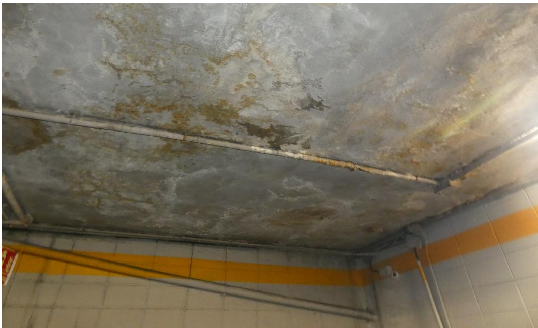
Figura 1-2 Ejemplo paño de forjado de sótano -2 con alto nivel de humedad percibida.
