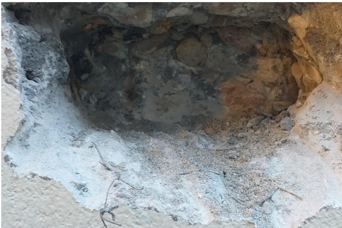
Figura 2-54 Cata en muro entre rampas.
