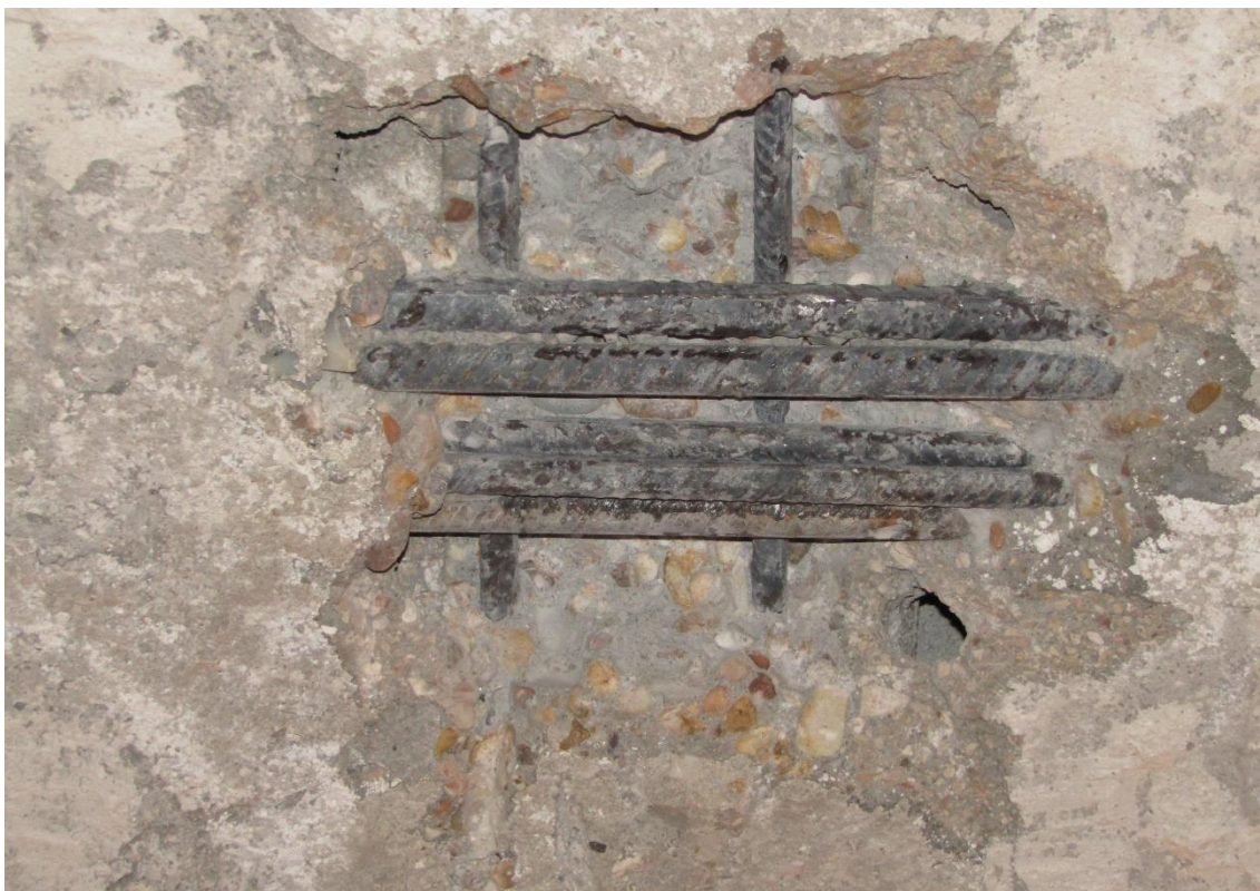
Figura 2-4 Cata P1-3. Acero sin pérdida de corruga. Signos de humedad en el hormigón alrededor de la cata.
