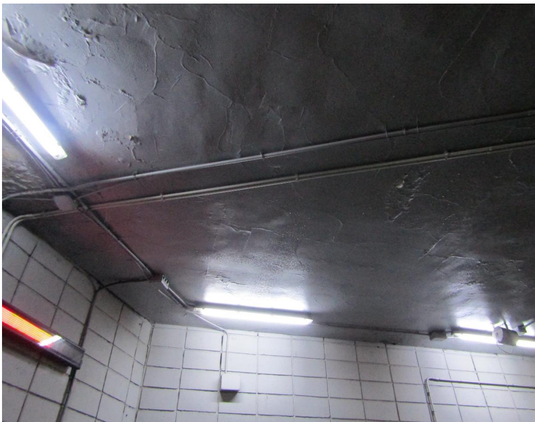
Figura 1-18 Agrupación de agua en un distintivo "efecto reticular".
