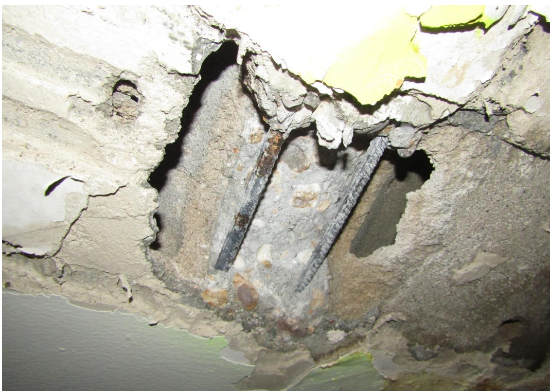
Figura 2-49 Cata P4-11. Acero sin pérdida de corruga. Signos de humedad en el hormigón alrededor de la cata.
