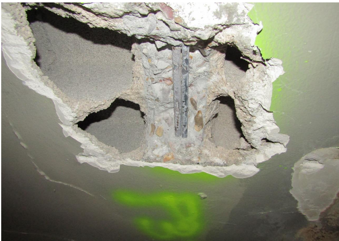
Figura 2-36 Cata P3-9. Acero sin pérdida de corruga. Signos de humedad en el hormigón alrededor de la cata.
