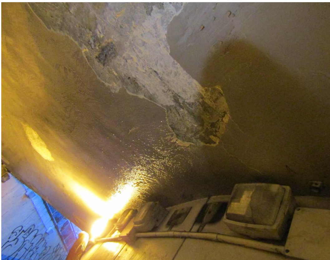
Figura 1-16 Acumulación de agua en toda la superficie del paño.
