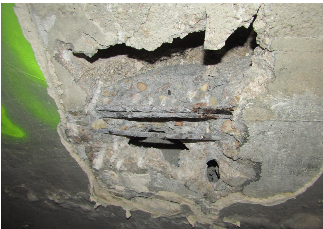
Figura 2-17 Cata P2-3. Acero sin pérdida de corruga. Signos de humedad en el hormigón alrededor de la cata.
