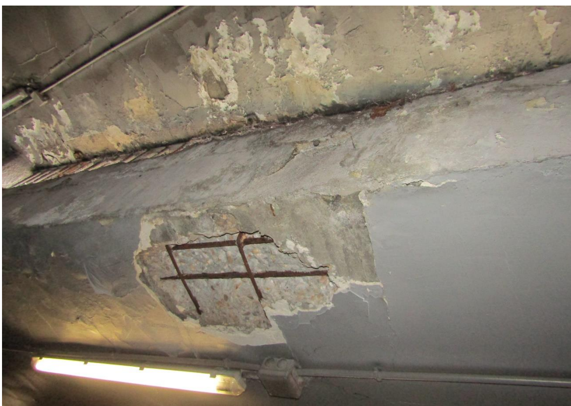
Figura 2-9 Cata P1-8. Acero con pérdida de corruga y pérdida de sección.
