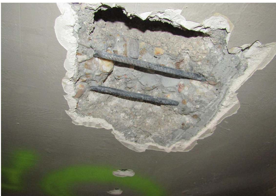
Figura 2-34 Cata P3-8. Acero sin pérdida de corruga. Signos de humedad en el hormigón alrededor de la cata.
