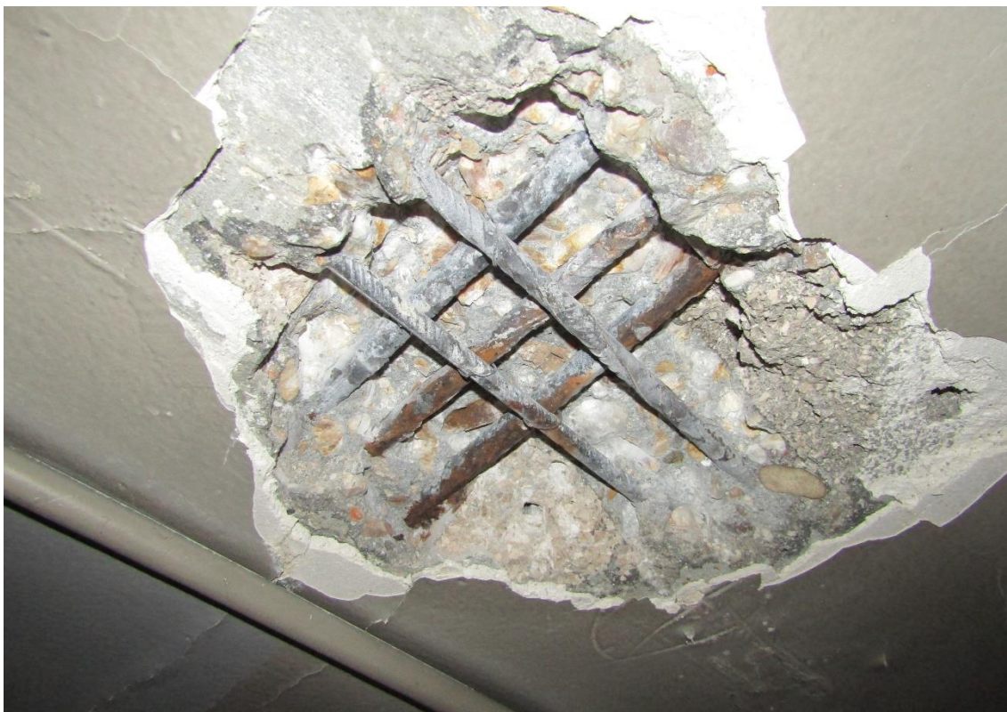
Figura 2-20 Cata P2-5. Acero sin pérdida de corruga. Signos de humedad en el hormigón alrededor de la cata.
