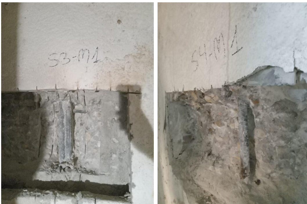
Figura 1-2. Catas en muro sótano -3 (izquierda) y muro sótano -4 (derecha)
