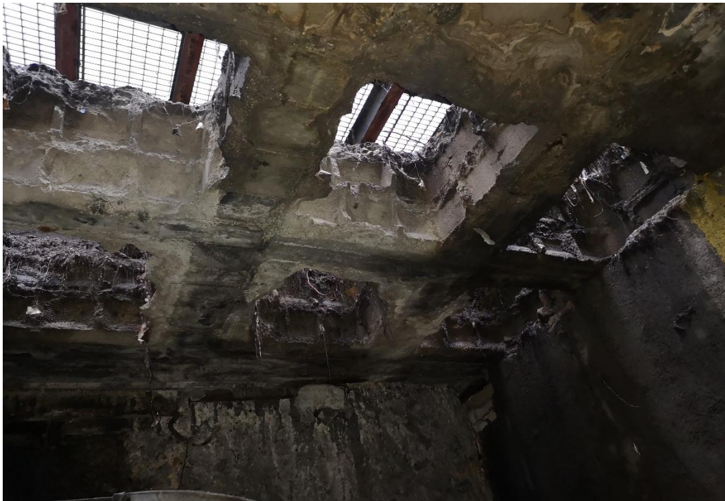
Figura 1-10 Detalle estampadores dañados.
