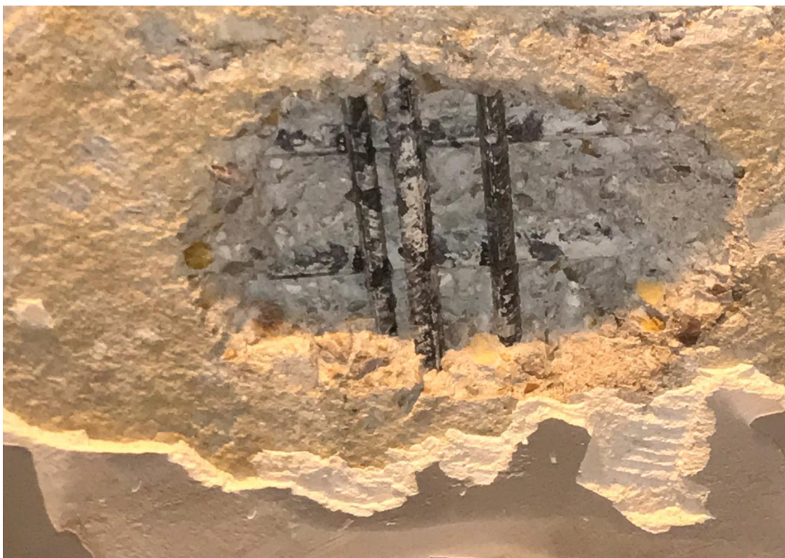
Figura 2-3 Cata P1-2. Acero sin pérdida de corruga. Signos de humedad en el hormigón alrededor de la cata.
