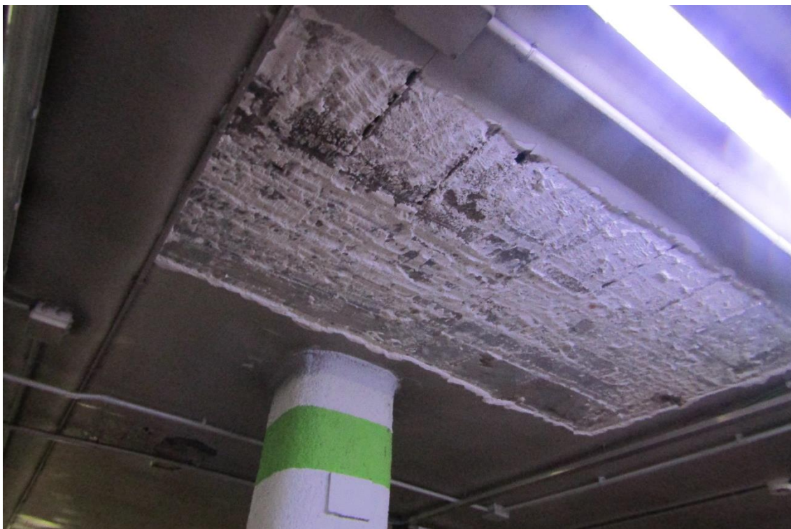
Figura 2-58 Descubrimiento del revestimiento 2m x 1m, techo del sótano -3.
