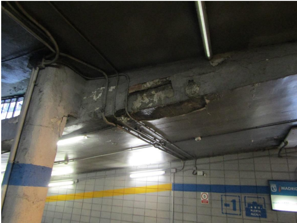
Figura 1-5 Daños en la rampa de bajada desde la plaza al sótano -1.
