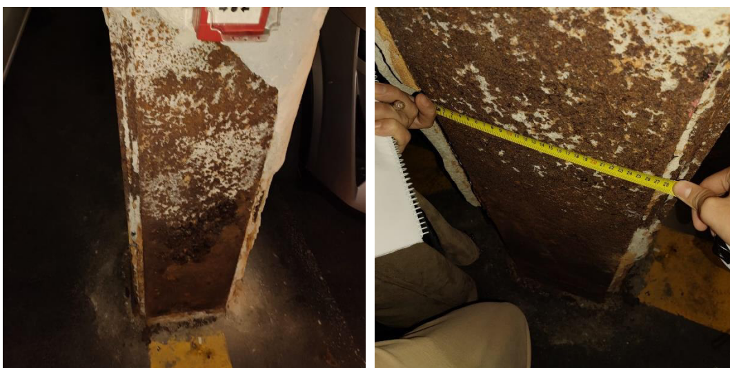
Figura 1-3. Pilar metálico sin protección (izquierda) y medida del ancho (derecha)
