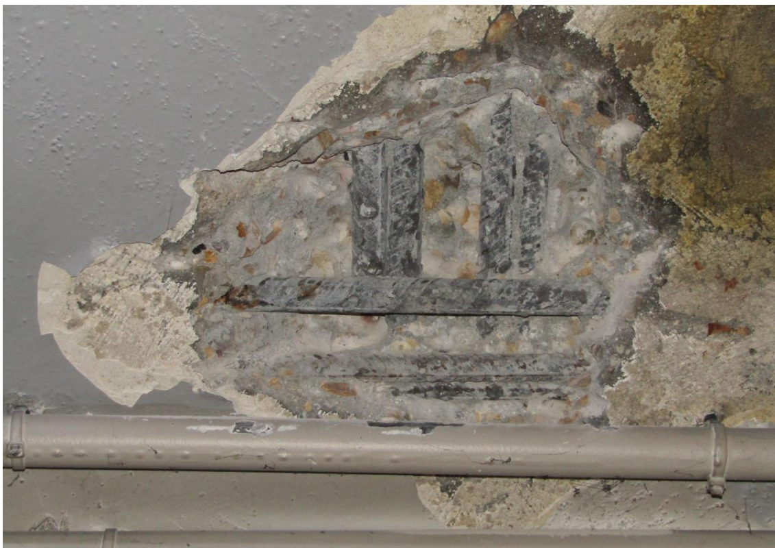
Figura 2-6 Cata P1-5. Acero sin pérdida de corruga. Signos de humedad en el hormigón alrededor de la cata.
