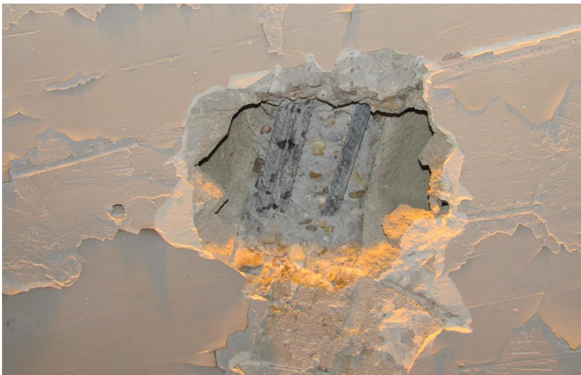
Figura 2-14 Cata P1-13. Acero sin pérdida de corruga. Signos de humedad en el hormigón alrededor de la cata.
