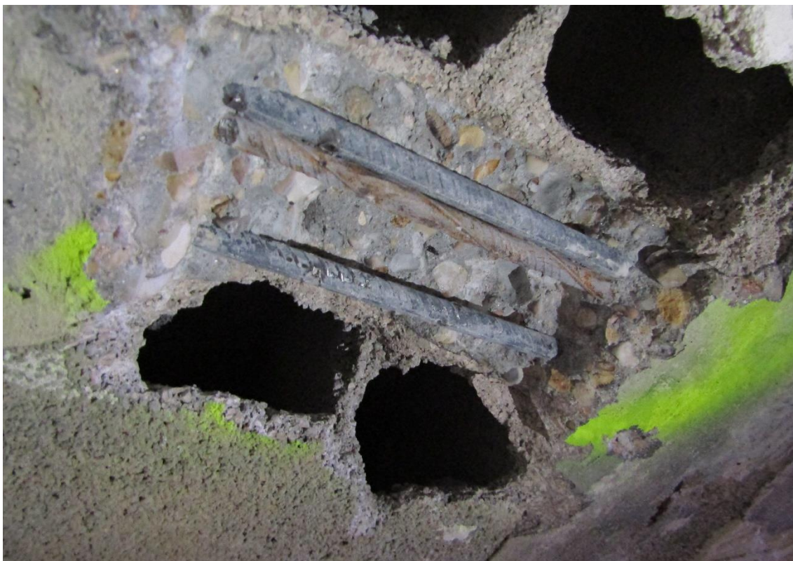
Figura 2-24 Cata P2-9. Acero sin pérdida de corruga. Signos de humedad en el hormigón alrededor de la cata.
