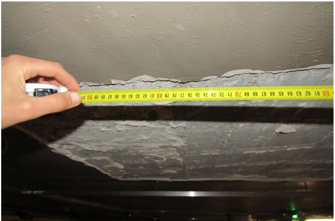
Figura 2-57 Medición ancho ábaco desde la cara del pilar, techo del sótano -2.
