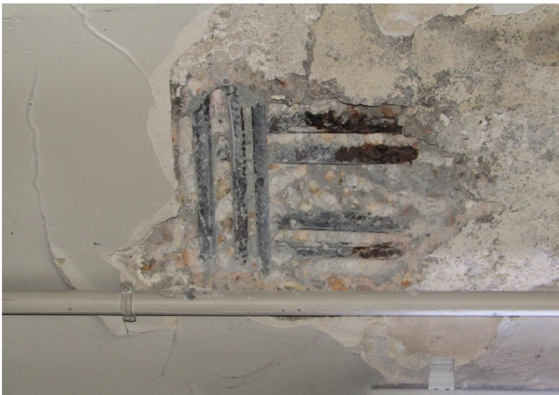
Figura 2-12 Cata P1-11. Acero sin pérdida de corruga. Signos de humedad en el hormigón alrededor de la cata.
