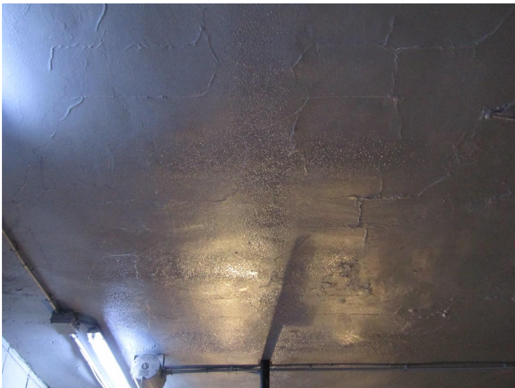
Figura 1-19 Agrupación de agua en un distintivo "efecto reticular", observable a simple vista.
