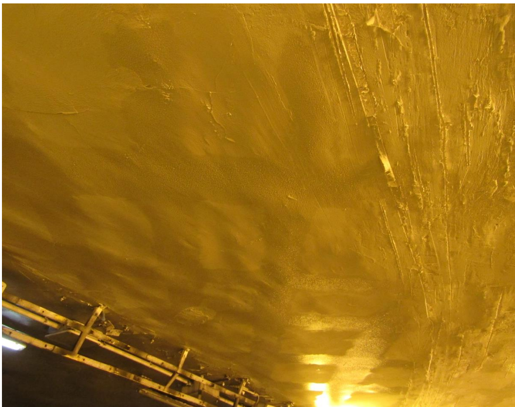
Figura 1-17 Agrupación de agua en un distintivo "efecto reticular", fácilmente observable a simple vista.
