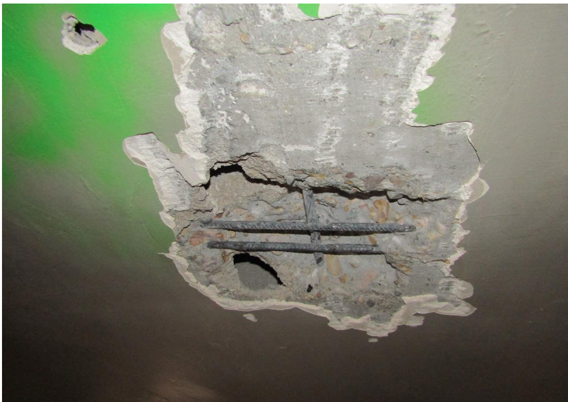
Figura 2-35 Cata P3-8'. Acero sin pérdida de corruga. Signos de humedad en el hormigón alrededor de la cata.
