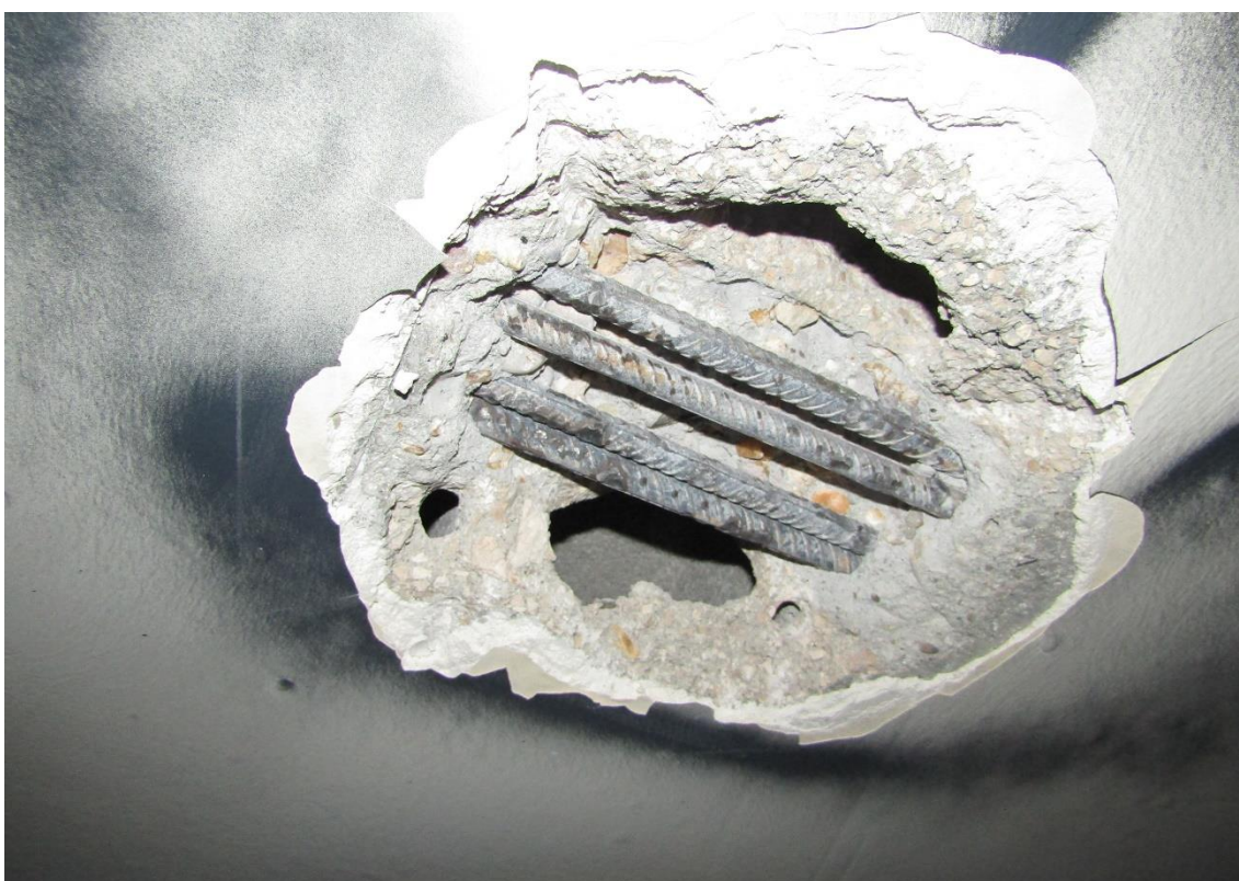
Figura 2-41 Cata P4-3. Acero sin pérdida de corruga. Signos de humedad en el hormigón alrededor de la cata.
