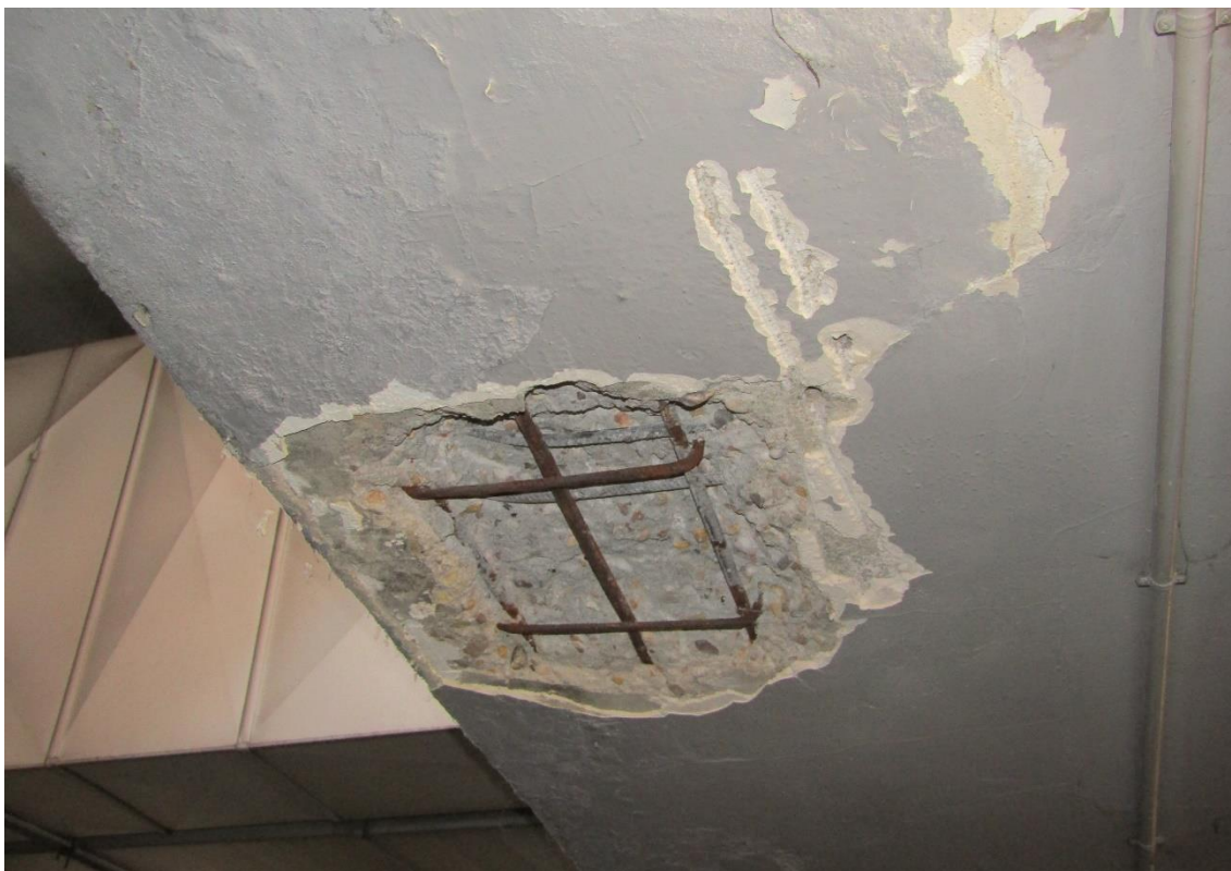
Figura 2-10 Cata P1-9. Acero con pérdida de corruga y pérdida de sección.
