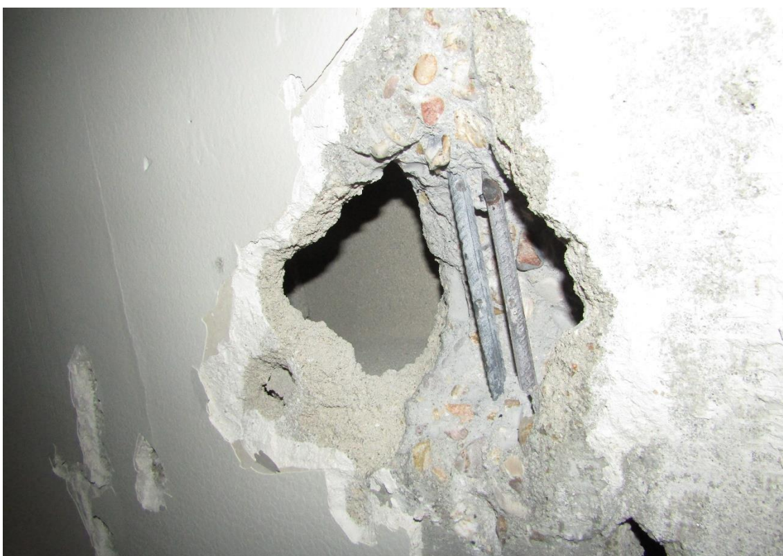
Figura 2-45 Cata P4-7. Acero sin pérdida de corruga. Signos de humedad en el hormigón alrededor de la cata.
